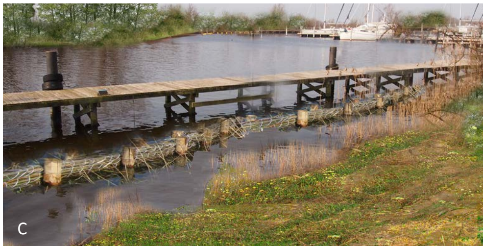
Figuur 3.12C. Inpassing van wilgentenen als vervangende beschoeiing.
